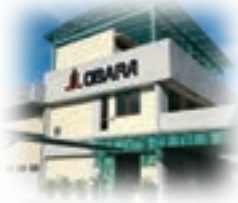
マレーシア新工場
