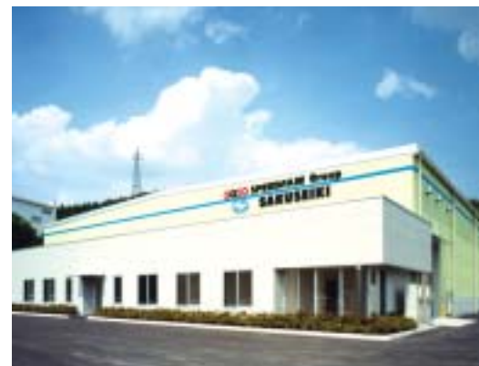
所在地：長野県佐久市 / 土地面積：16,971 m 2 / 工場面積：2,016 m 2
